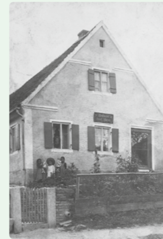
Erstes Wohnhaus und Geschäftsstandort Meyer, Bauerngasse
