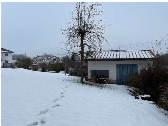
Blick Richtung Norden
